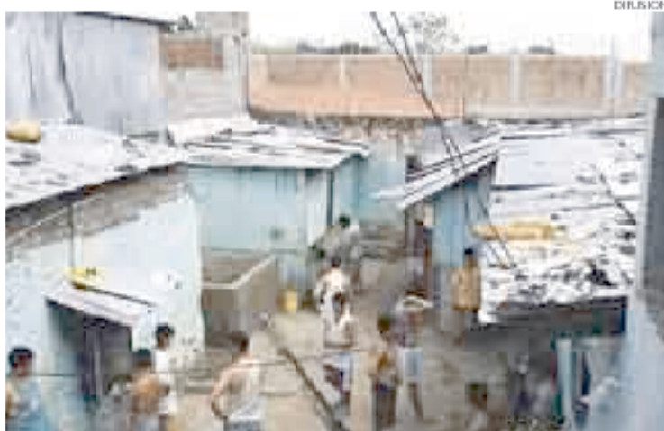
► MALAS CONDICIONES. El penal cuenta con una deficiente infraestructura.
